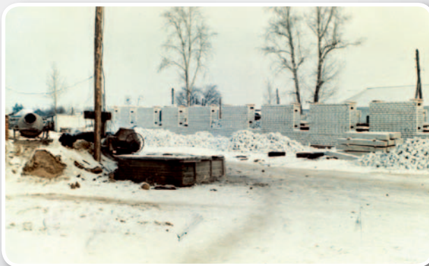
Строительство Усть-Ивановского дома-интерната
